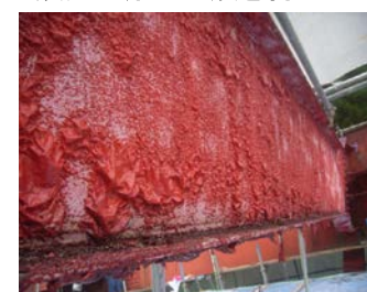
塗膜剥離剤処理
